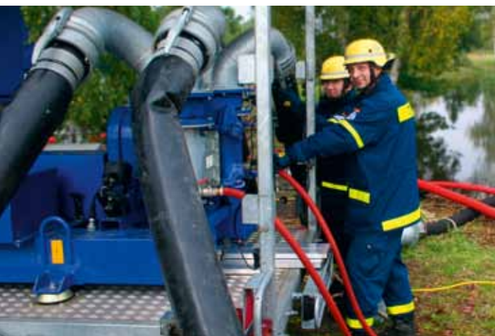
THW im Hochwassereinsatz an der Schwarzen Elster
